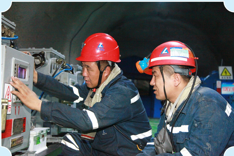
图为该矿工排查安全隐患。 韩顺过 摄
